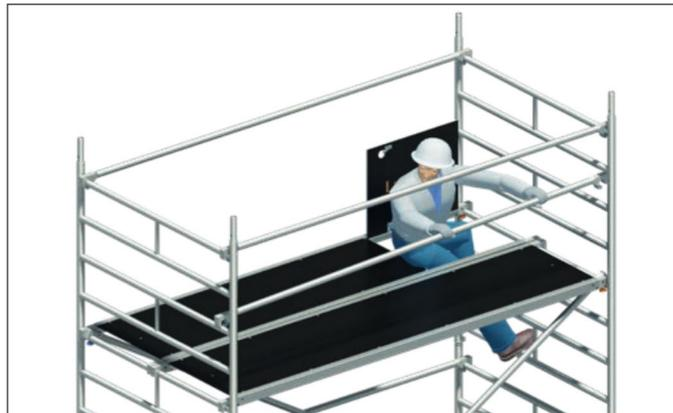
3. In der Durchstiegsöffnung sitzend, erfolgt die Demontage der Zwischengeländer, hierzu werden die bereits unter 2. einseitig gelösten und aufgelegten Geländer 14 auf der Seite der Durchstiegsklappe ausgehoben.
