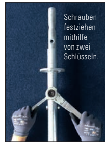
Bild 32: Die Muttern mit entsprechendem Werkzeug fest anziehen.
