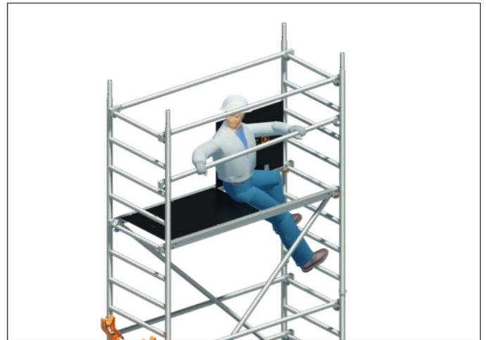
5. Innenseitiger Aufstieg über die Sprossen der Standleiter durch die dafür vorgesehene Durchstiegsklappe. In der Durchstiegsöffnung sitzend, absturzgesichert durch die Holme der Durchstiegsbrücke 26, erfolgt die Montage des Zwischengländers der nächsten Lage, hierzu werden die Geländer 18 an den zweiten Sprossen über der Standfläche montiert.
